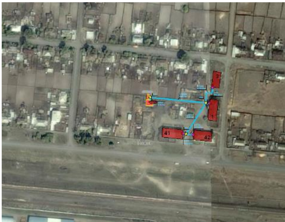
Рисунок 5. Тепловые сети котельной №1.
